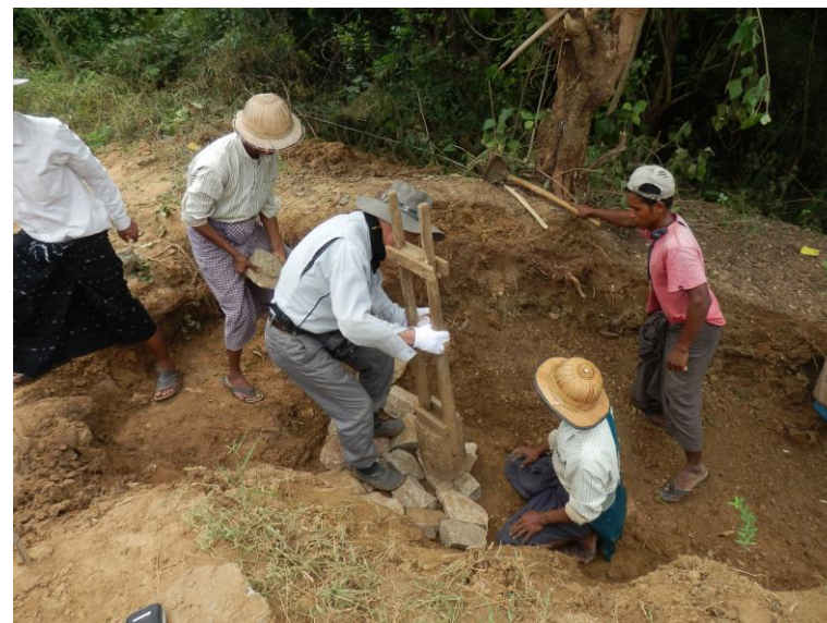
専門家自ら実践し、施工法を説明
